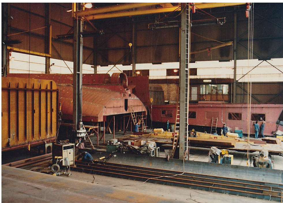
Hal 12 is een enorme verbetering. Hele stukken van het schip kunnen binnen in elkaar gezet en voorbereid worden.
