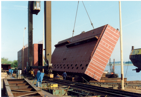
De binnen geassembleerde stukken worden op de helling aan elkaar gelast. Hier eens een ander verhaal: de wanden van een dok.
