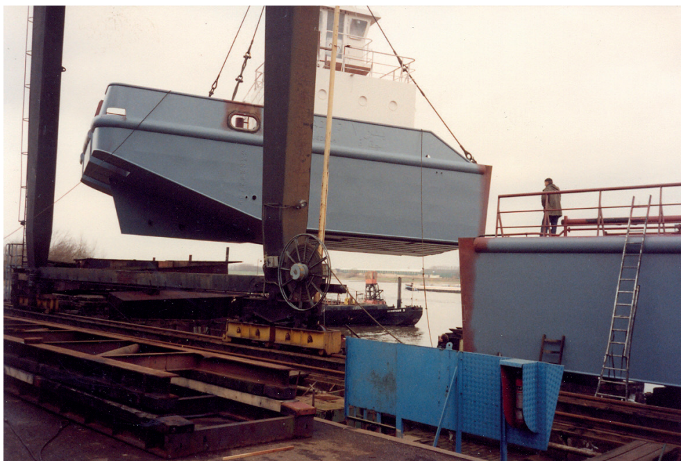
Met behulp van de bokkraan wordt het middendeel van een pontje geplaatst om samen te voegen met het deel dat al op de helling staat.
