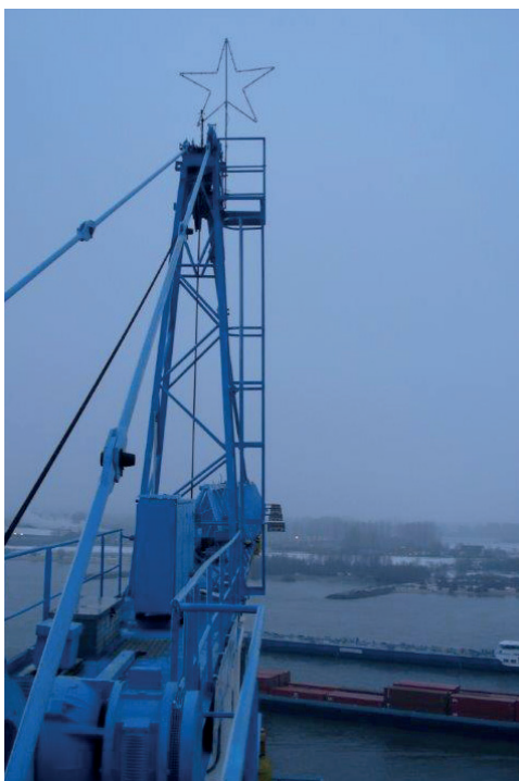
De Kerstster in de torenkraan
