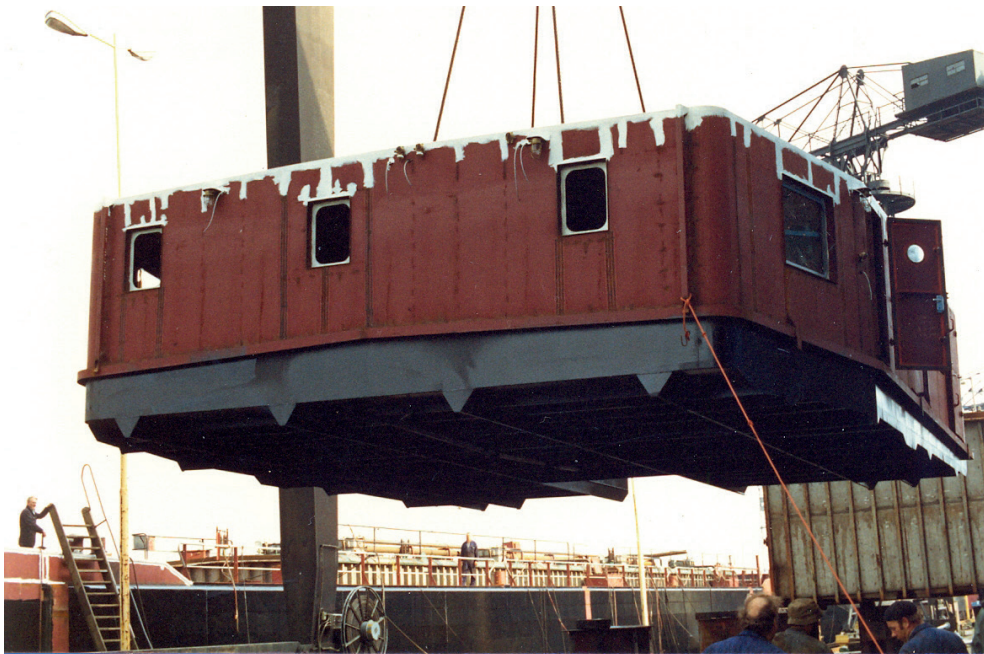
De roef van een binnenvaartschip wordt op het achterdek geplaatst met behulp van de bokkraan.
